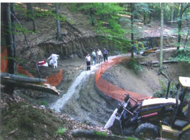
Grobišče Bodovlje, priprava dostopa do grobišče, 8. 9. 2005
