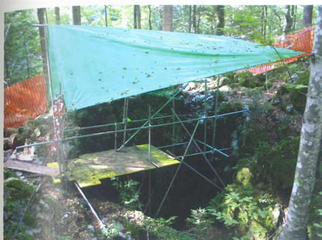
Brezna pri Konfinu 1. Izdelava kovinske konstrukcije in zaščitne strehe nad breznom. Za spuščanje in dvig ljudi in materiala so izvajalci uporabili škripčevje z elektromotorjem, 11. 9. 2006 (foto M. Ferenc).
