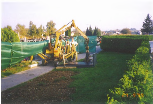
Pokopališče Dobova, prostor izkopa, 24. 9. 1999 (vir D. Omersa)
