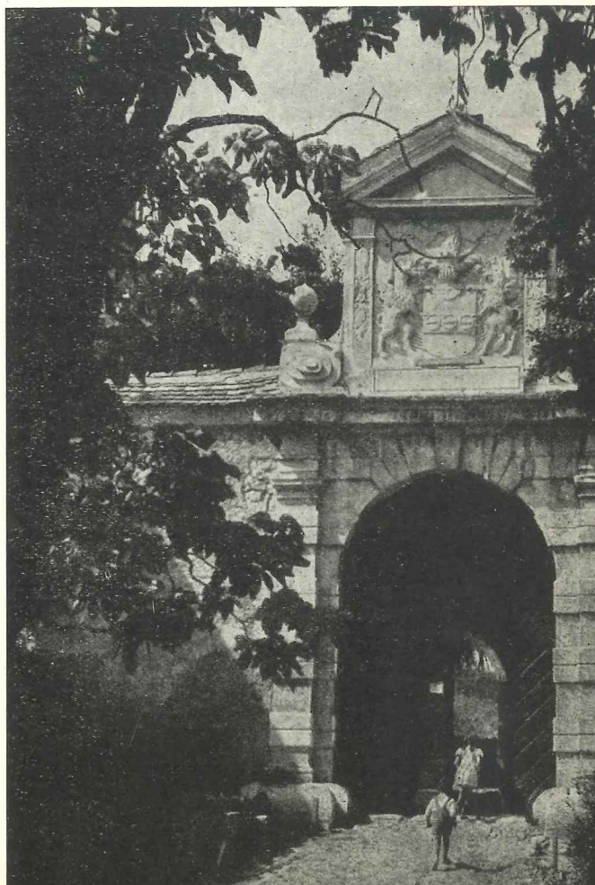
Portal notranjega dvorišča
