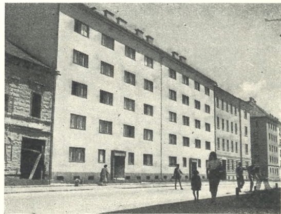
Sl. 2. Maribor. Na prostoru porušenihiš novo zgrajeni hiši v Ulici kneza Koclja št. 23 in 25 ter obnovljena hiša št. 27
