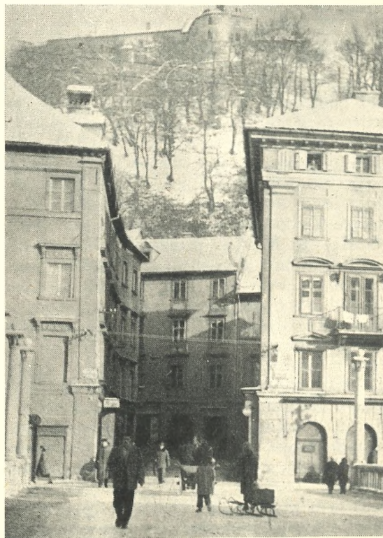
Sl. 4. Pogled s Čevljarkega (Gornjega) mostu proti stavbišču nekdanjega Komuna oz. Tranče
