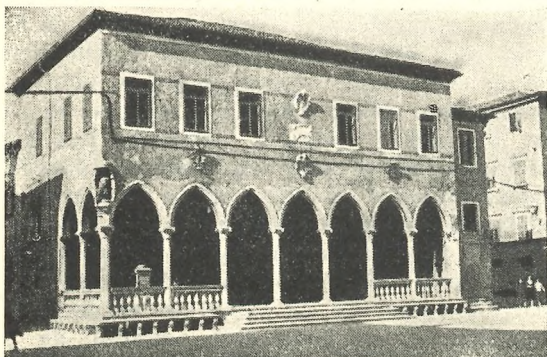
Loggia v Kopru
