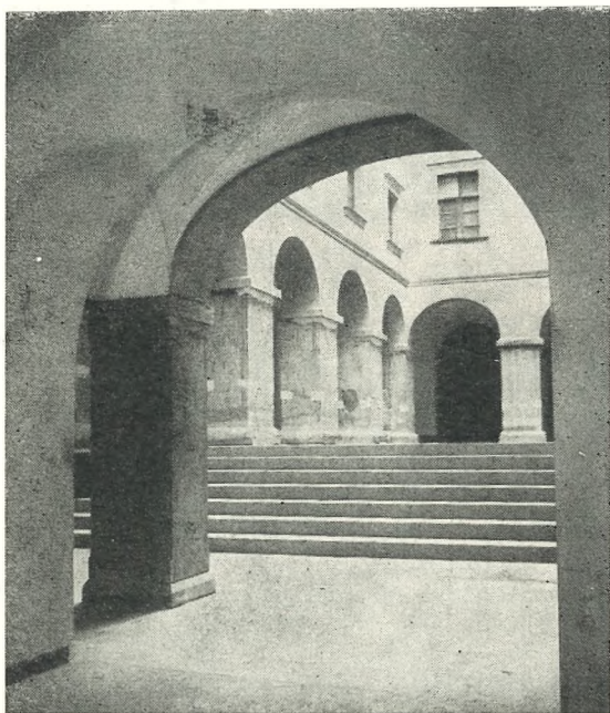
Severno magistratno dvorišče z očiščenimi in obnovljenimi oboki
