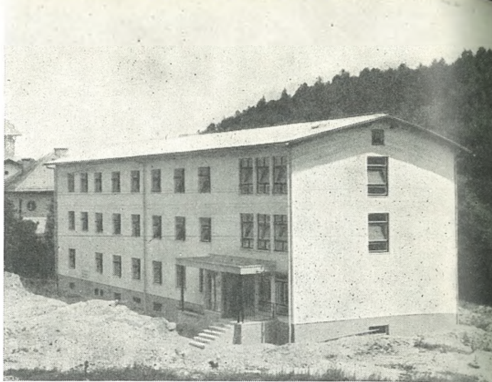
Samski dom Mestne kanalizacije v Ljubljani
