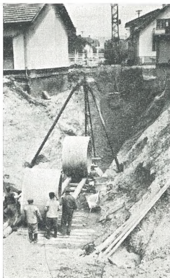
Gradnja zbirnega kanala \phi 180 cm
