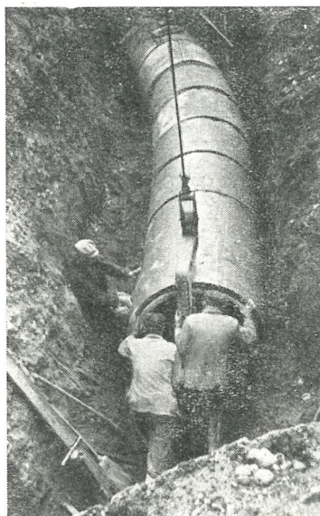
Gradnja zbirnega kanala \phi 140 cm
