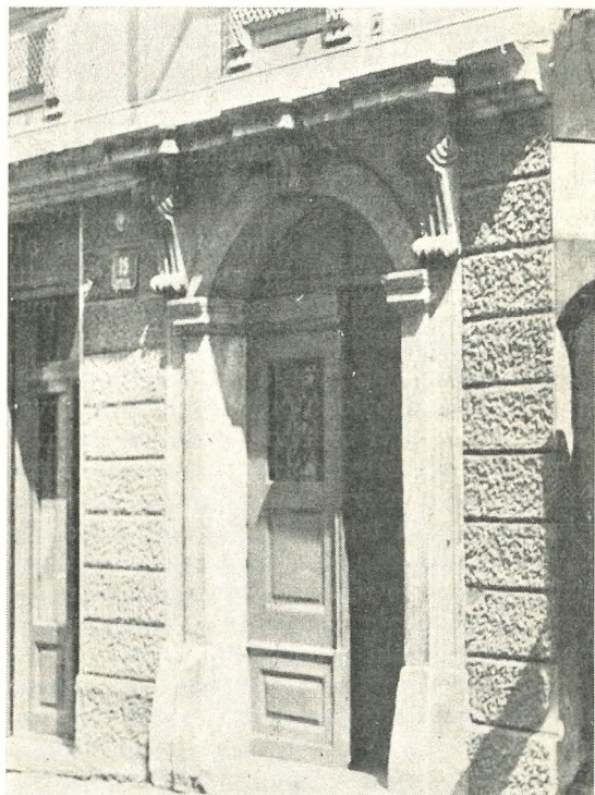
Portal hiše št. 15 na Gornjem trgu
