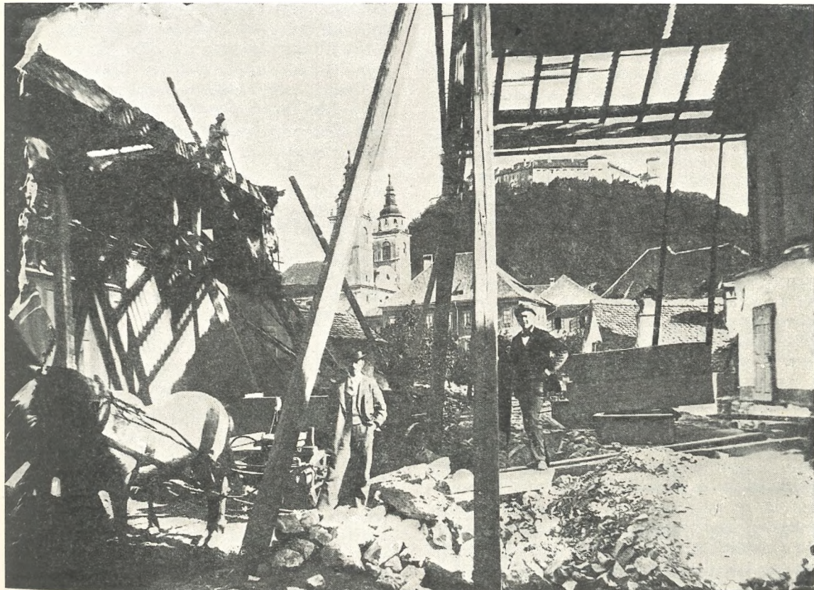
Ruševine na Sentpetski cesti (sedaj Trubarjeva ulica) po potresu leta 1895
