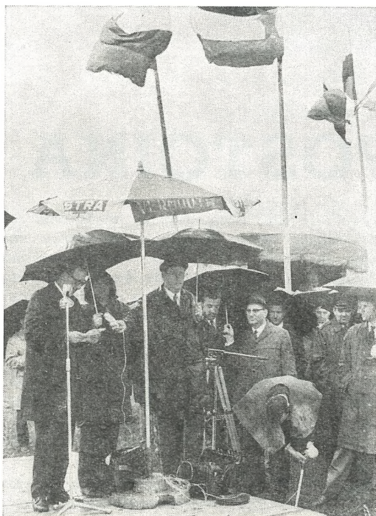
Na slavnosti ob začetku del na cesti Vrhnika—Postojna je spregovoril tudi generalni direktor industrijskega gradbenega podjetja »GRADIS« v Ljubljani ing. Hugo Keržan
