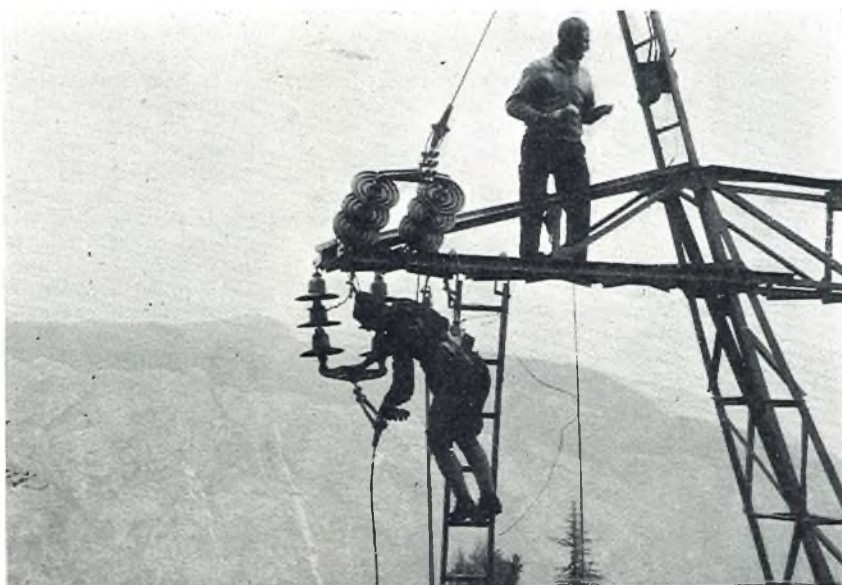
Delo na stebru 10 kV daljnovoda Ukanc—Vogel
