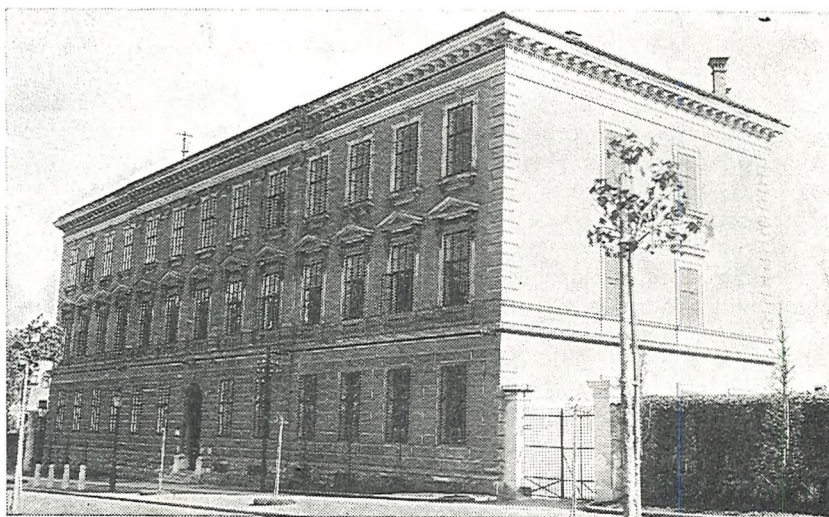
II. deška osnovna šola — Graben — zgrajena 1875
