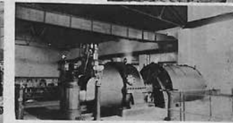
Pogled na notranjčino elektrarne s turbogeneratorjem v ospredju.
