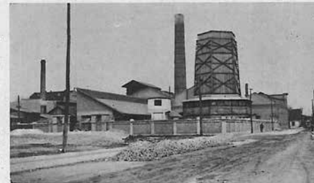
Pogled na ljubljansko elektrarno od Šole na .Ledini. Na desni: Leseni stolp za ohlajevanje kondenzacne vode. — Spodaj: Parna turbina Škodovih zavodov, ki proizvaja 4100 HP.
