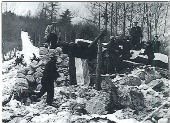
Gradnja skakalnic v Planici.
