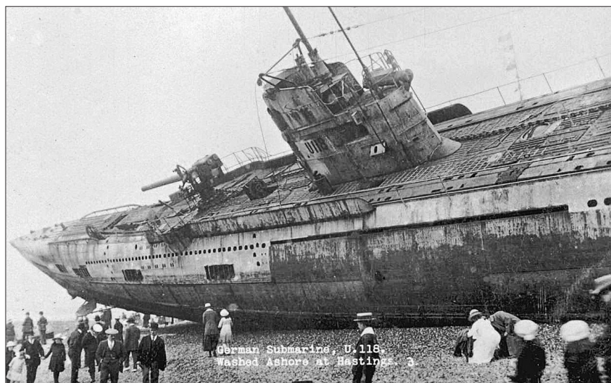
Na sliki so lepo vidne vojne oznake U118 na poveljniškem stolpu, pred njim sprednji top, odprtine na trupu za vodni balast in sprednja globinska krmila na premcu.
