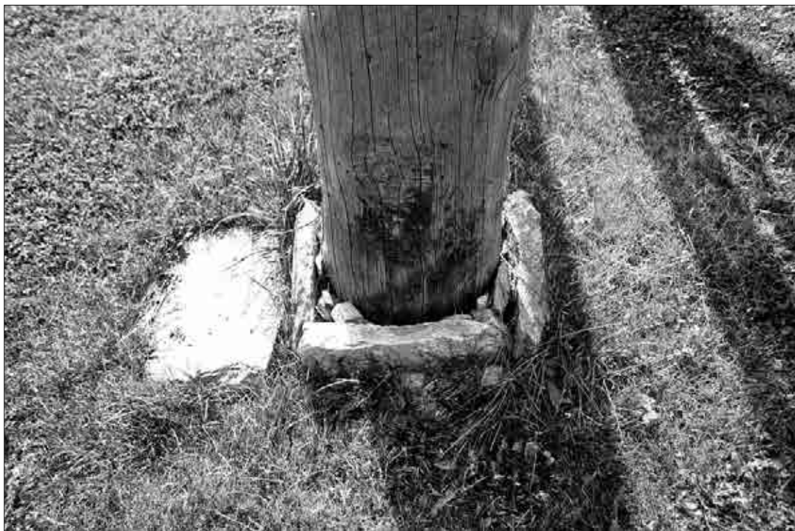
Slika 7: Jama za leseni kol, obdan s kamni, ki tvorijo ustrezno in stabilno lego temeljenja. Postavljeni leseni kol je zagozden z drobirjem, ki se opira na ploščate robne kamne. V arhitekturi temu točkovnemu temelju pravimo čaša. Švica, Dandrio (foto: Domen Zupančič).
