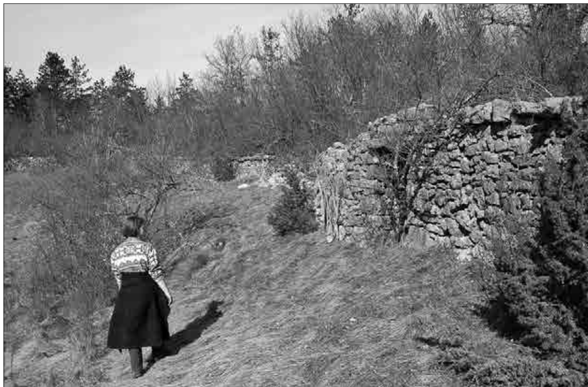
Kosovelje, hiška v Tilhovi dolinici, zgrajena v griži, ki se nadaljuje v zid (foto: E. Belingar, 2013).
