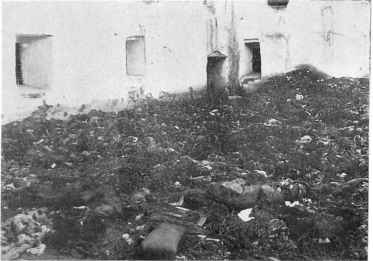
Dans la cour des casemates de la forteresse de Niche. Effets appartenant à des personnes massacrées.
