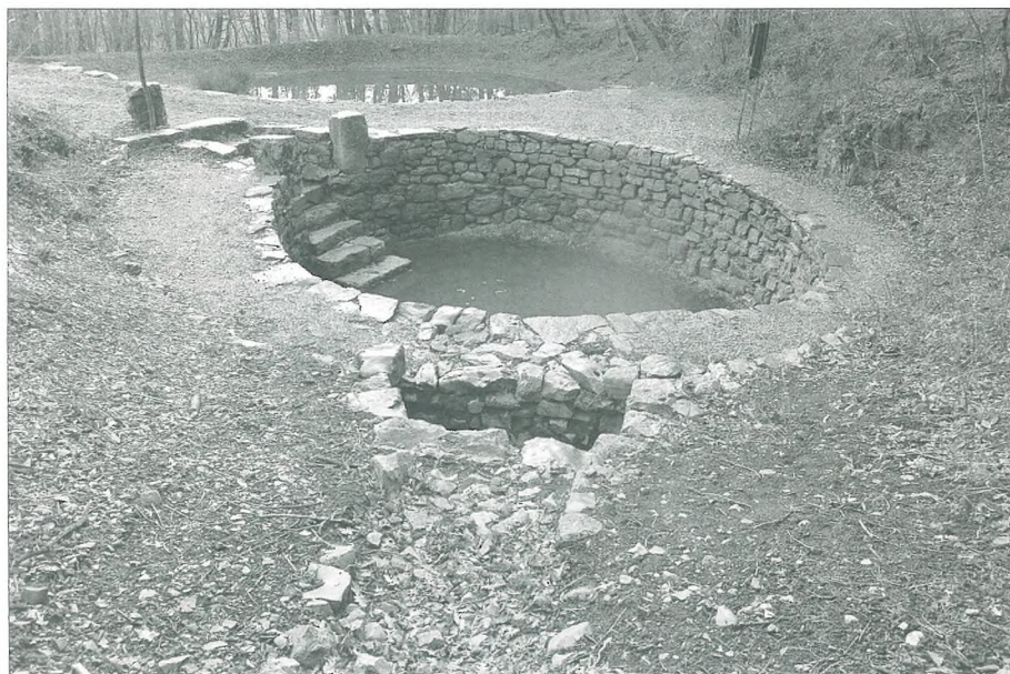
Hrpelje, Štirnica. Za dostop do vode so uredili stopnice, pred izpustom vode v štirnico pa čistilnik.
