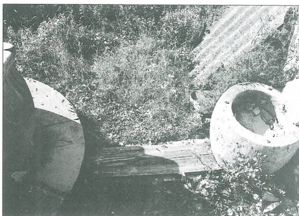
Enostavnejši odprti čistilnik na domačiji Kazlje 16. Voda je iz žlebov pritekla na kamenje v čistilniku, od tam pa po kanalu v tleh do vodnjaka. Foto: E. Bellingar, 2009.
