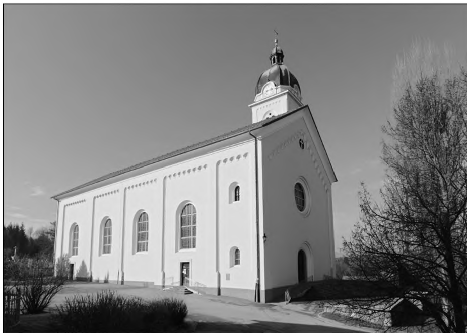
Karl Rösner, župnijska cerkev sv. Urha, Smlednik, 1847–1849, zunanjsčina s severovzhoda. 7
