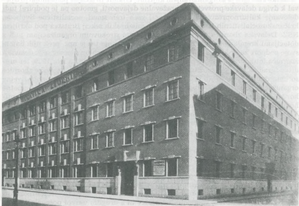
Nova palača delavske zbornice za Slovenijo v Ljubljani, v kateri so imele od leta 1929 sedež strokovne organizacije ter nekatere druge delavske organizacije in ustanove
