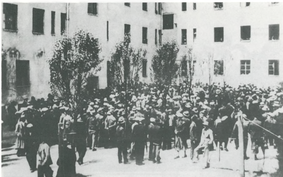
Stavkajoči gradbeni delavci na dvorišču delavske zbornice v Ljubljani junija 1936
